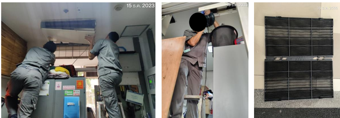
รูปที่ 2-34 ล้างเครื่องปรับอากาศพื้นที่ส่วนกลาง
