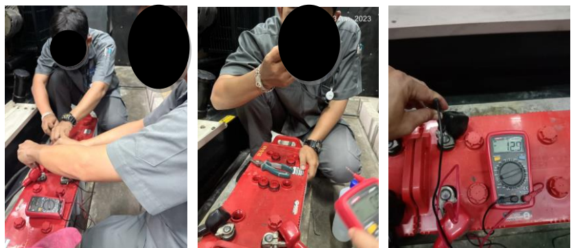
รูปที่ 2-14 เจ้าหน้าที่ตรวจสอบเครื่องกำเนิดไฟฟ้าสำรอง
